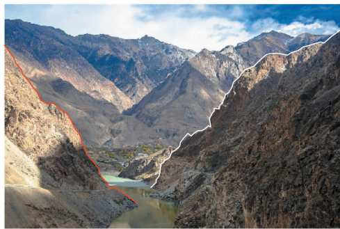
图 13 某交通线路怒江特大桥超高陡复杂斜坡
