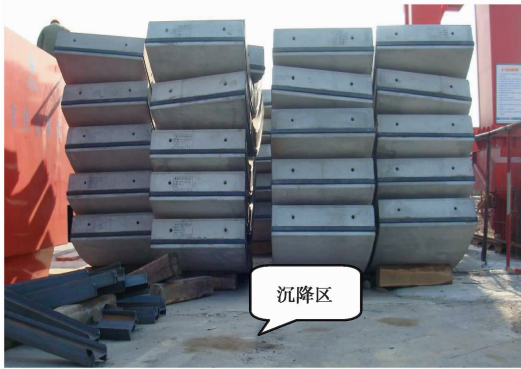
图7 人工填土引起的地表沉降
