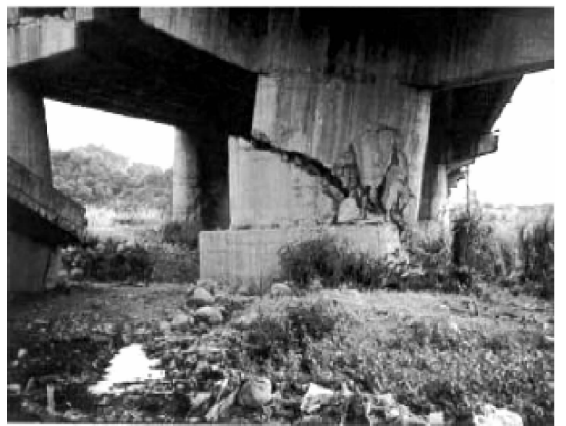
图 3 墩的剪切破坏
