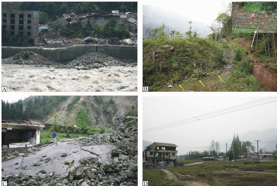
图2 汶川地震地表变形特征及建筑物破坏情况
